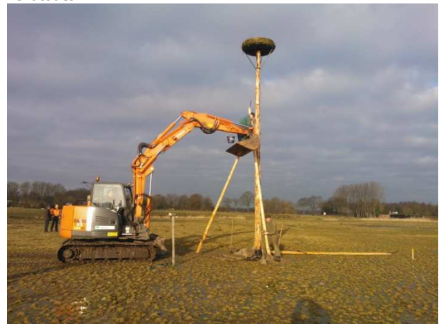
De paal wordt gestabiliseerd
