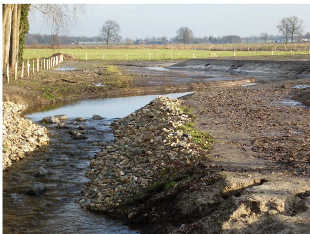
Gilzewouwerbeek in aanleg 12 dec. 2012
